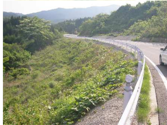
施工地 地震発生後 路面のひび割れや沈下の発生無し
